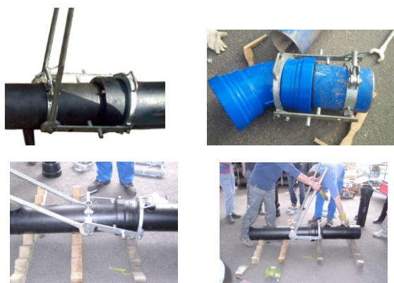
Figura 5 - Fasi di "imbicchiamento delle tubazioni"
